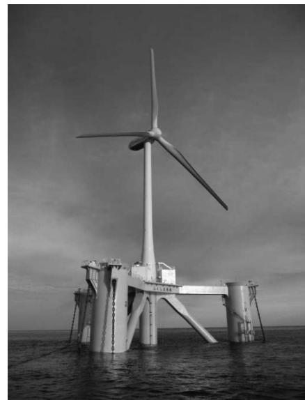
写真-8 設置完了後の2MW級洋上風力発電船の状況
