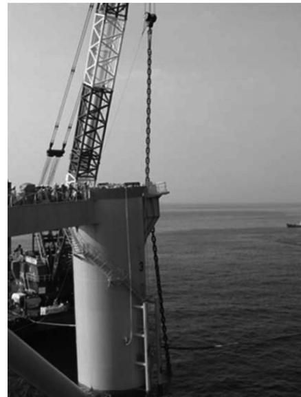
写真-7 500t吊クレーン台船による係留チェーン引上げ作業の状況
