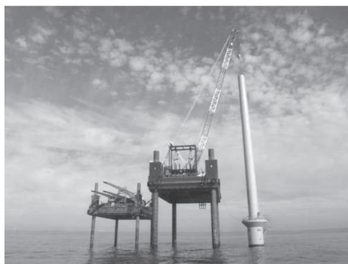
写真-8 風車タワー据付状況
