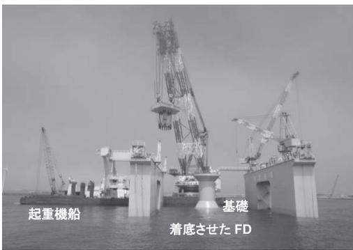
写真一4 基礎の積替 (FD → 起重機船)
