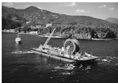
DP 船による深層水取水管敷設作業
