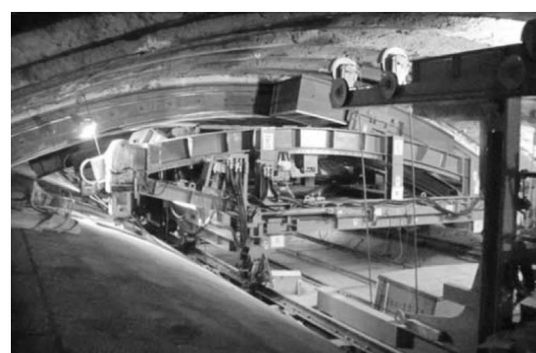
写真—2 アーチセグメント組立装置
