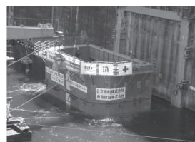
写真—1 浮体式仮締切設置状況
