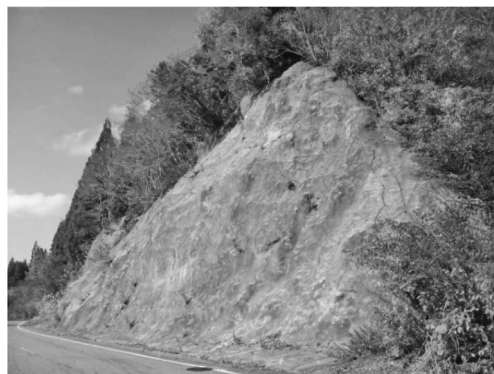
写真—1 吹付工の施工（例）
