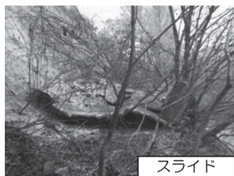
写真—3 吹付材と背面地山の境界面の劣化による老朽化現象 (例)
