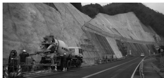
写真一八 開発した吹付システムの施工状況（例）
