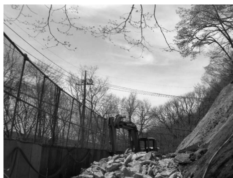
写真—5 重機によるはつり取り (例)
