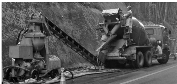
写真一七 湿式吹付機の設置状況（例）
