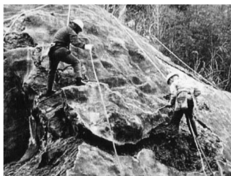
写真—6 人力によるはつり取り (例)
