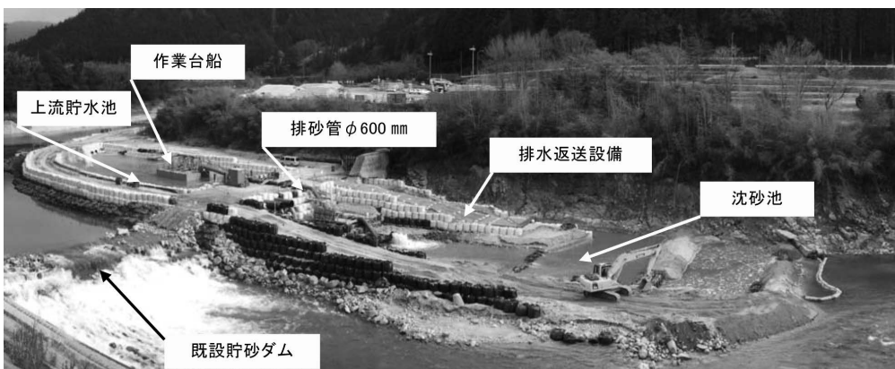
写真一 1 実験施設全景
