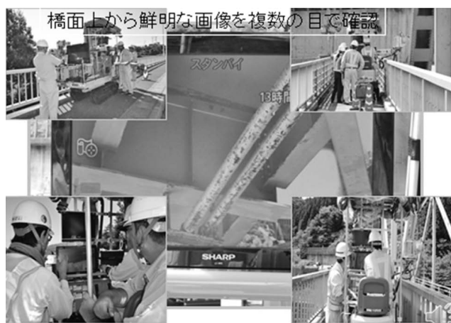
写真—14 モニター画面と複数技術者による確認
