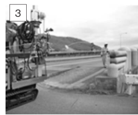
写真—10 移動時水平アーム先端部を補助員固定誘導
