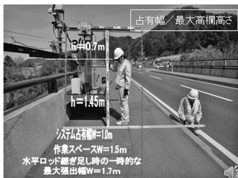
写真—12 橋面歩道に設置する場合の例
