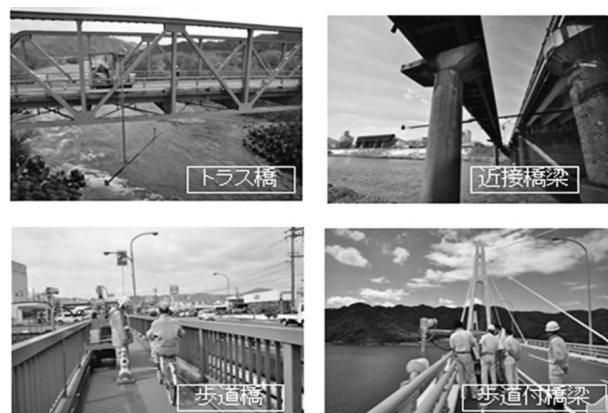
写真—15 点検車が利用出来ない橋梁の例
