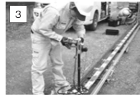
写真—8 カメラ台車・ケーブル取付け
