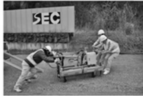
システム台車方向転換 作業員3名で実施
