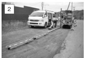
写真—6 現場着からシステム降車仮置き(約5分)
