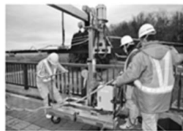
現地組立後点検位置への移動
