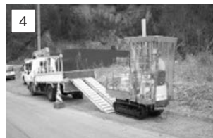
写真—6 現場着からシステム降車仮置き(約5分)
