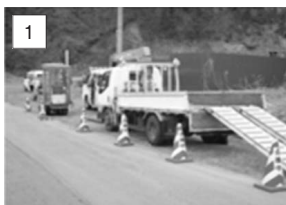
写真—6 現場着からシステム降車仮置き(約5分)
