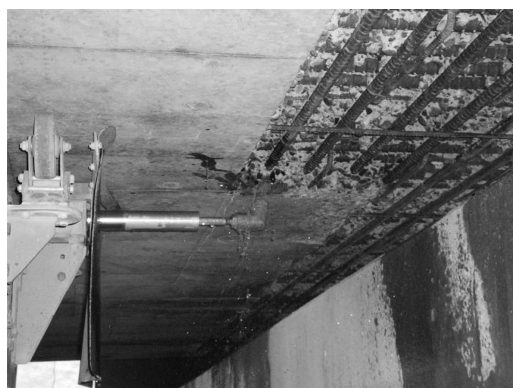
写真一2 はつり状況
