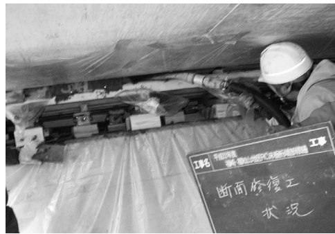
写真一5 充填状況写真
