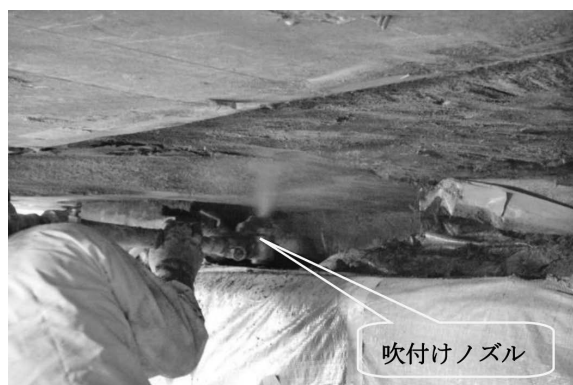
写真—5 吹付けによるのはつり部の断面修復状況
