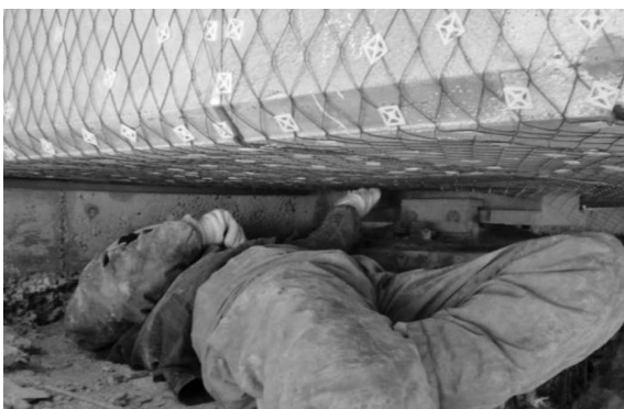
写真-1 狭隘部におけるチタンメッシュ陽極設置状況
