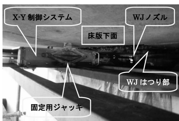
写真—3 X-Y制御ウォータージェットはつり装置
