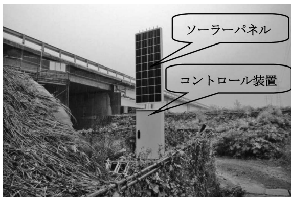
写真-11 ソーラー電源装置の設置後の状況
