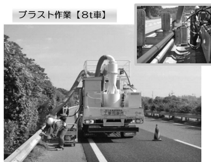
写真—2 ブラスト作業状況
