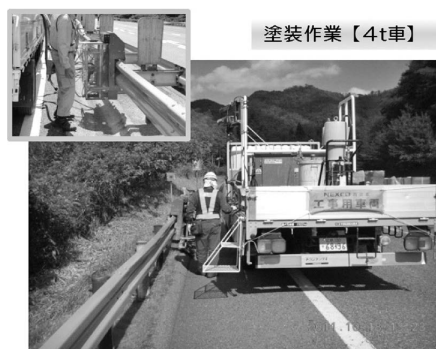
写真—3 塗装作業状況
