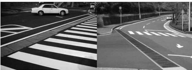
写真一〇 横断側溝の施工
