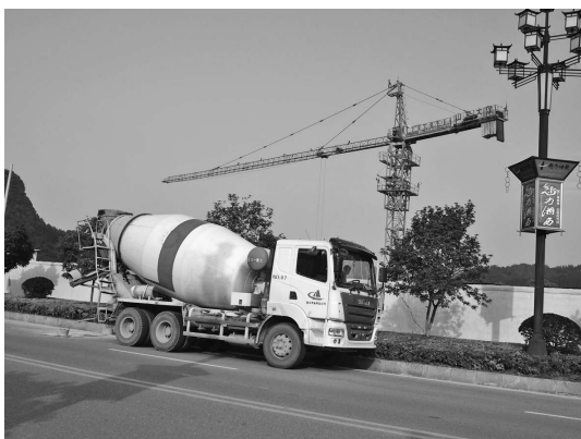
写真一七 ホテル周辺で作業中のトラックミキサとコンクリート打設ブーム
