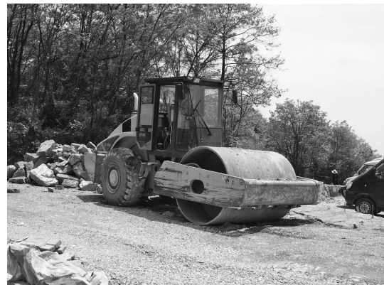
写真一〇 張家界周辺の工事現場で駐機中のコンバインドローラ
