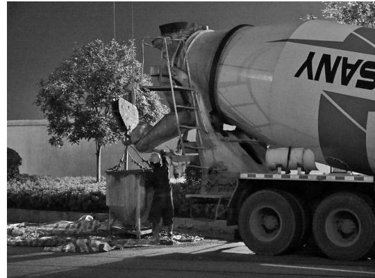
写真一八 夜間作業中のトラックミキサ（バケットへコンクリート投入）
