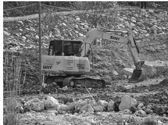
写真一九 張家界周辺の工事現場で駐機中の油圧ショベル
