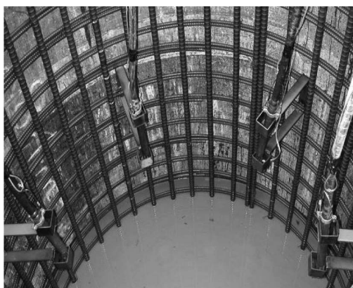
写真-1 杭頭バイブレータ設置状況
