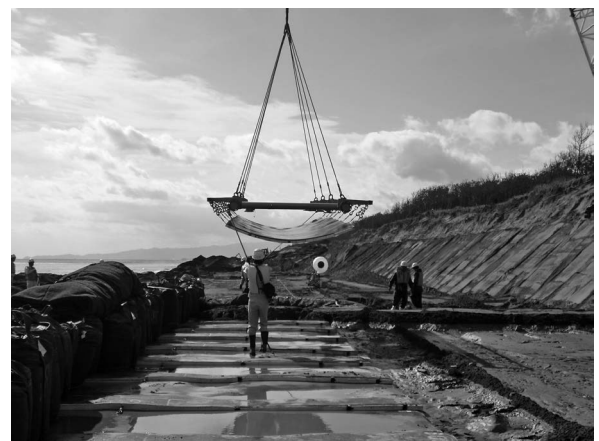
写真-6 施工状況 (アスファルトマット敷設)
