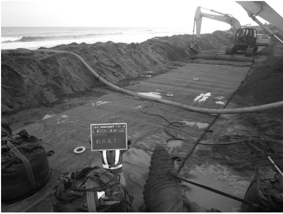
写真一七 施工状況 (袋材敷設)
