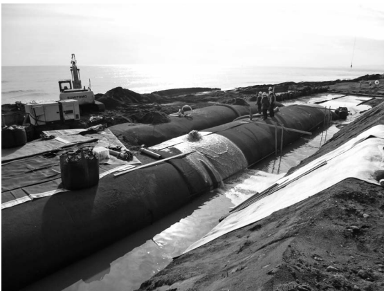
写真一八 施工状況 (中詰材充填)
