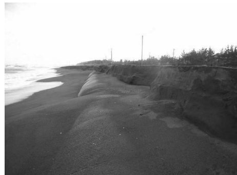
写真一2 砂浜になじんだサンドバック 福井県浜住海岸
