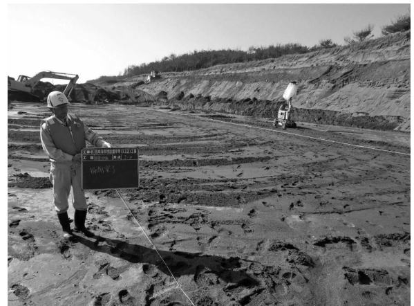
写真-5 施工状況 (床掘)
