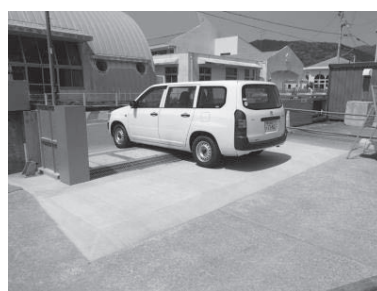
車両走行確認
