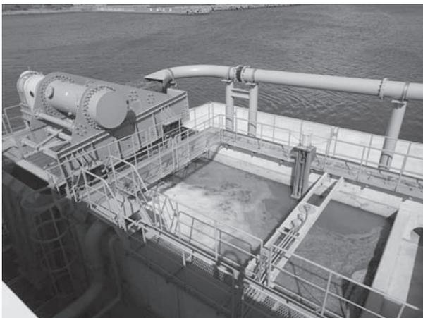
写真—8 振動ふるい(左)と調整槽
