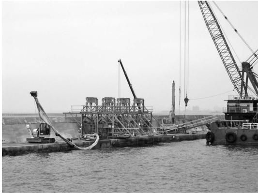
写真—3 中詰材撤去設備
