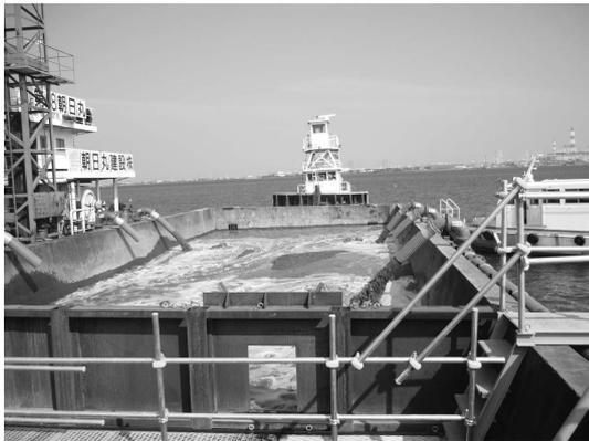
写真—4 中詰材の積込状況
