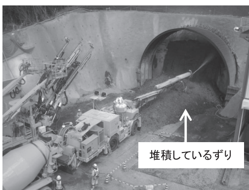
写真―8 本技術による坑口部の吹付け
