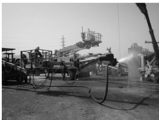
写真—5 模擬ロングブームを用いた吹付け試験状況
