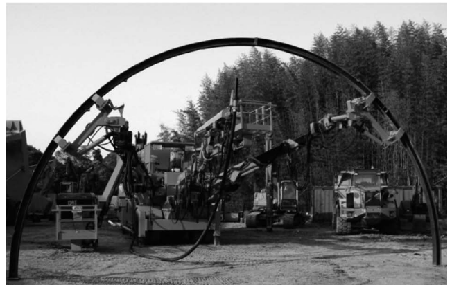
写真-4 エレクター体型吹付機
