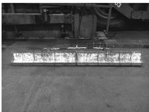
写真—1 L型ジョイントヒータ加熱状況
