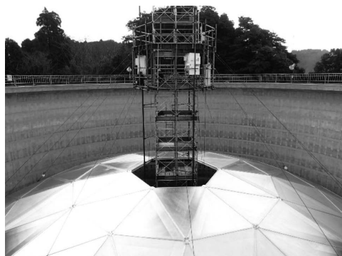
写真－1 アルミ屋根吊り上げ状況
