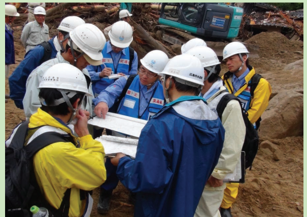
自治体等関係者と土砂撤去の工法検討状況
