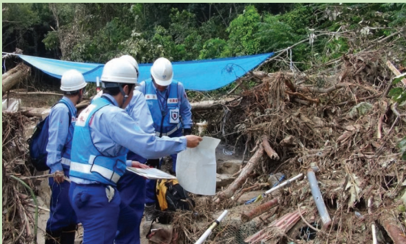
土石流発生箇所の緊急溪流点検
