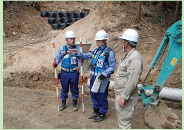
建設業者の方と応急対策工の打合せ
