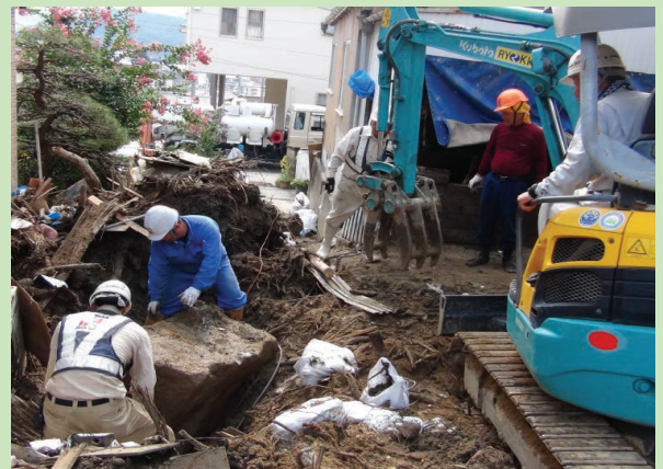
一日も早い復興のため懸命の作業を行う建設業者の方々
