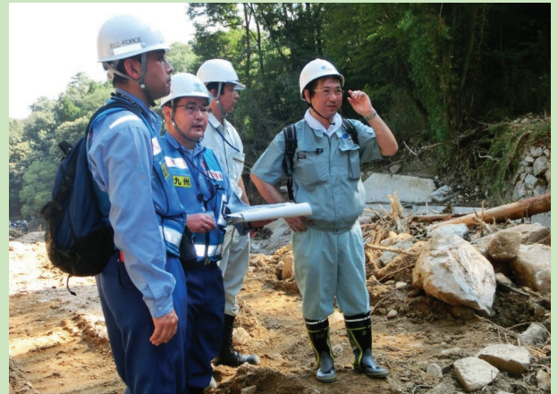
土木研究所等と応急対策工法の検討
