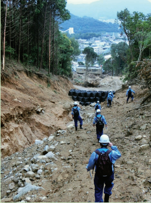
応急対策工箇所の現地確認
