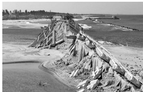
写真－1 東日本大震災における被害
