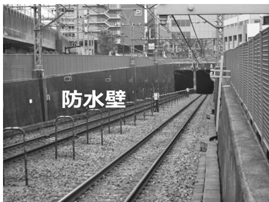
写真一3 防水壁
