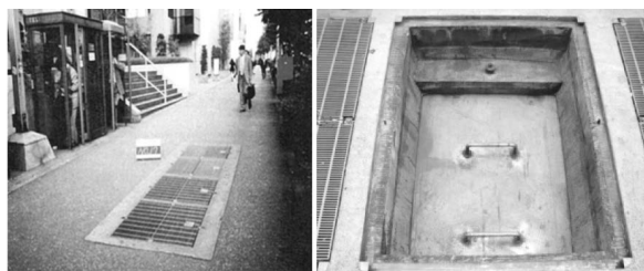
写真一6 換気口と浸水防止機
