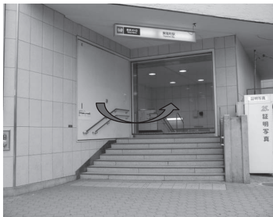
写真一2 駅出入口の嵩上げと防水扉
