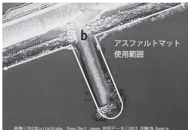
写真—5 大曲海岸突堤・緩傾斜堤（被災後）
