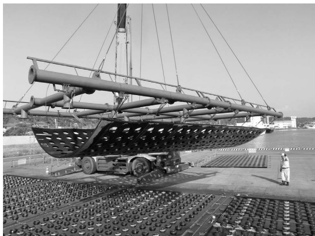
写真—9 全面孔あきアスファルトマット吊上げ状況
