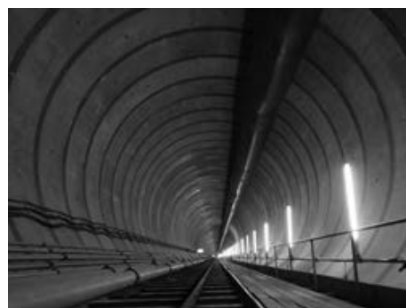
写真—1 シールドトンネル
