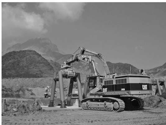
写真—4 鋼製透過型砂防堰堤の据付け状況
