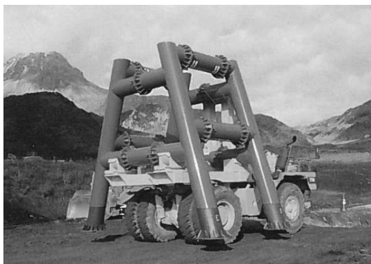
写真—3 鋼製透過型砂防堰堤の運搬状況
