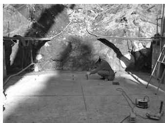
④アンカーボルト工
