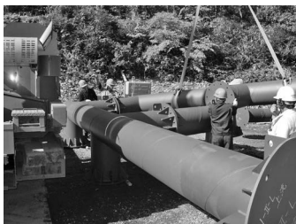
⑥部材架設
