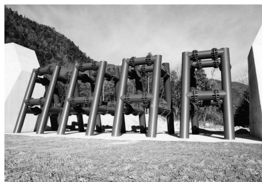
写真一1 鋼製透過型砂防堰堤の一例
