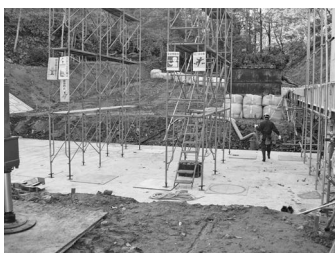
⑤足場組立
