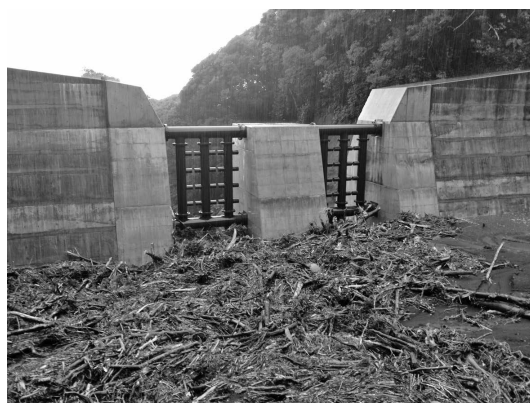
写真—8 捕捉事例③ 伊豆大島長沢
