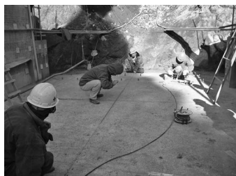
③測量・墨出し
