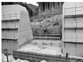
①床掘・整地均し 1次コンクリート打設
