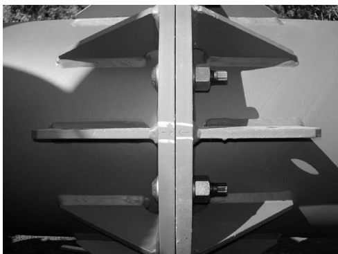
写真—2 ボルト接合（トルシア形高力ボルト）
