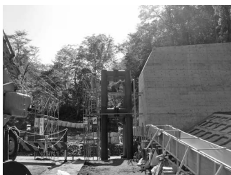
⑦高力ボルト締付け工
