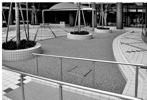
写真—1 学校構内における施工例（複層 POC）
