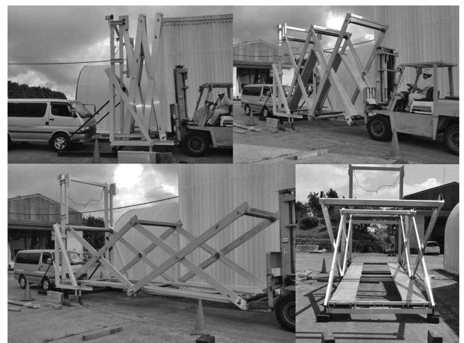
写真二 架設展開するモバイルブリッジ
