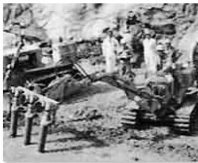
写真—7 草木ダムとマスコン打設用省人バイブレータ
