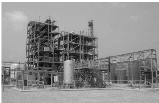
写真—4 二塔式ガス化炉
