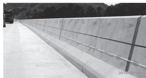
写真2 制御テープ貼付け状況
