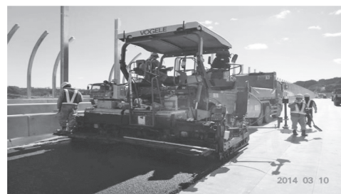
写真1 カメラアイ施工状況
