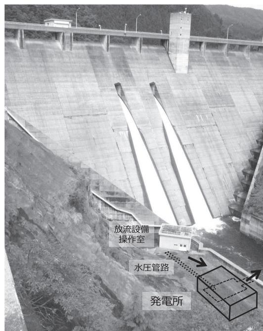
写真-3 阿多岐水力発電所概略図
