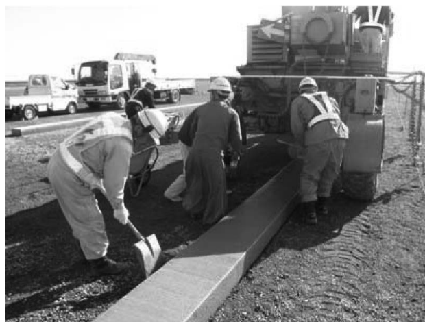
写真—12 コンクリート打設
