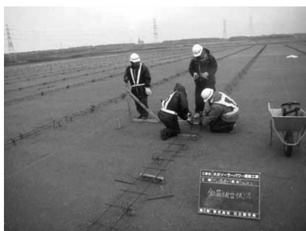
写真14 鉄筋組立状況
