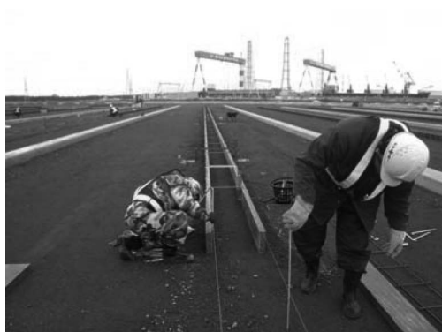
②型枠組み
