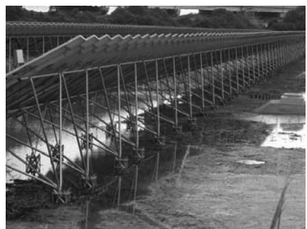
写真三 単管杭
