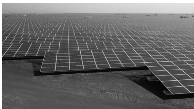
写真—7 パネル設置全景
