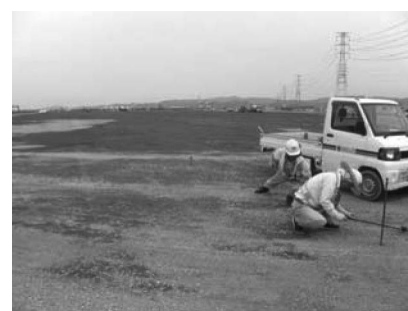
写真—20 ガイドロープ設置状況
