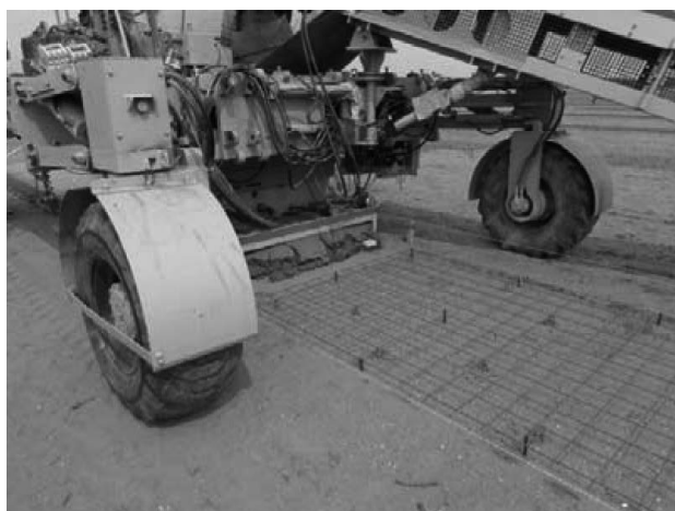
写真13 コンクリートが押し出される状況（参考）
