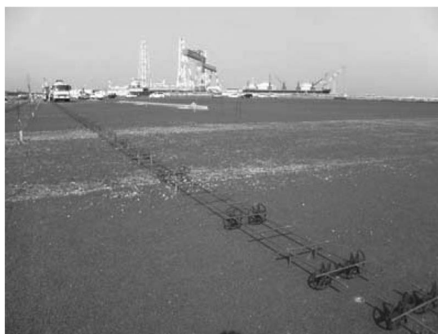
写真15 鉄筋固定状況
