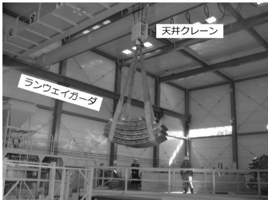
写真一8 防音ハウス内天井クレーン作業
