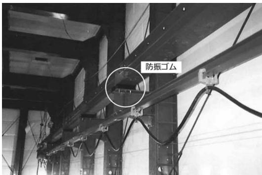
写真—9 防振ゴム施工例1
