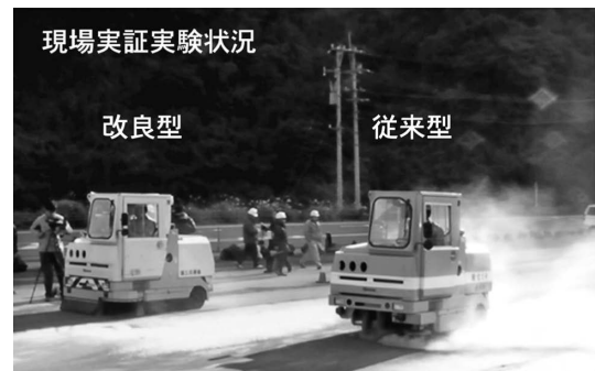
写真-4 現場実証実験状況
