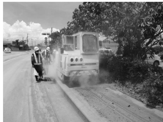
写真一1 現場踏査状況
