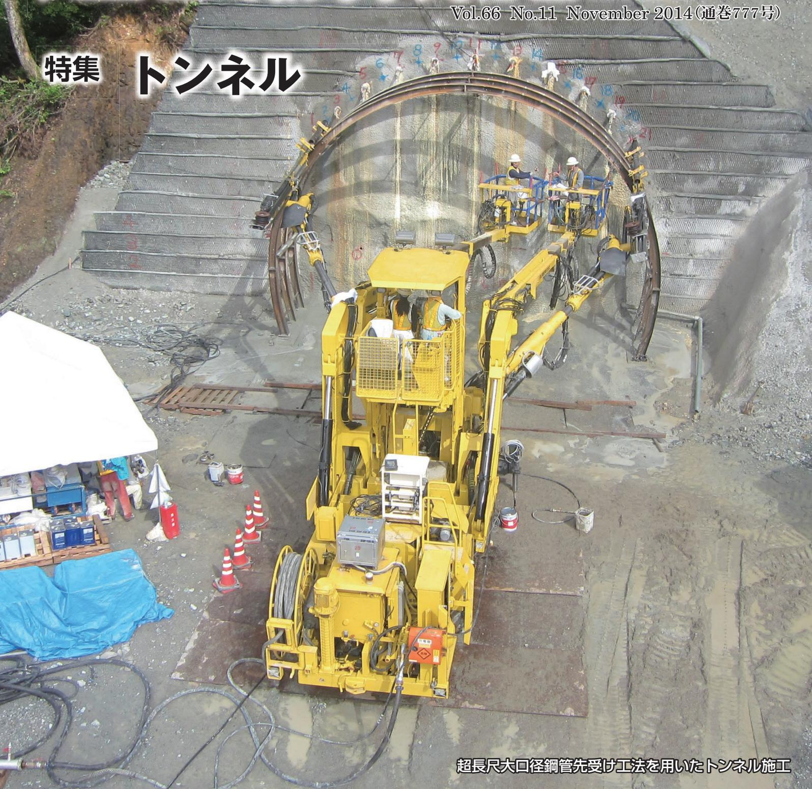
超長尺大口径鋼管先受け工法を用いたトンネル施工
