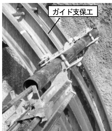
写真三 特殊鋼管受け治具使用状況
