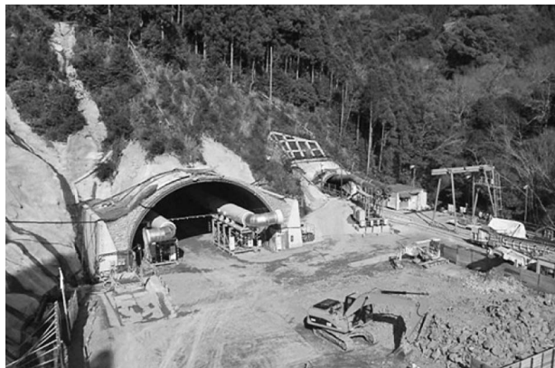
写真—1 トンネル坑口部全景
