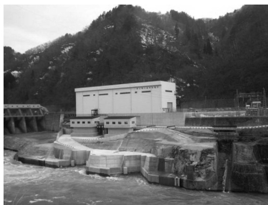
写真—9 豊実発電所竣工状況
