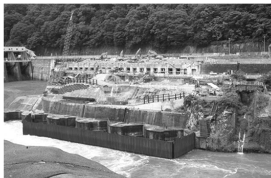
写真—2 建屋解体、放水路立坑掘削状況（平成 21 年 7 月）
