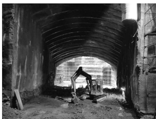
写真一7 発電所側掘削完了
