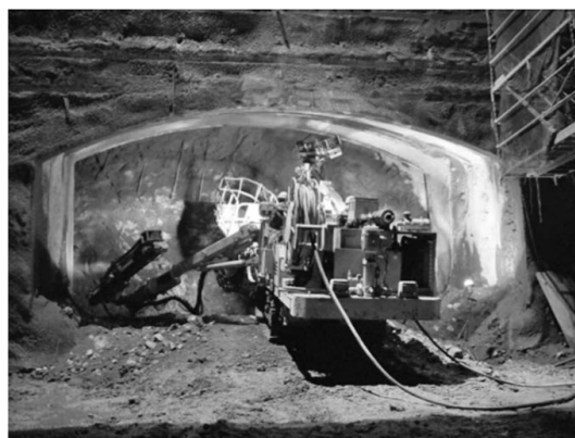
写真一6 放水口側削孔状況
