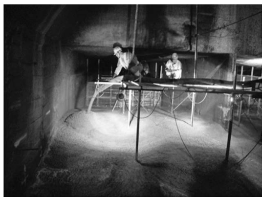
写真一5 既設放水路充填状況
