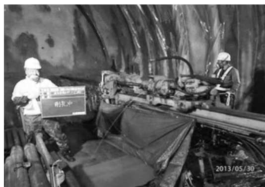
写真-3 水抜きボーリング施工状況
