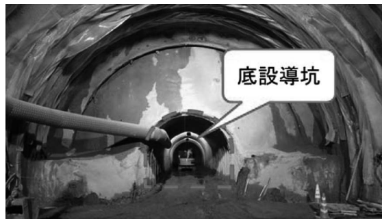
写真一 4 底設導坑の施工状況
