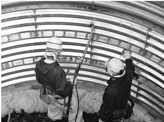
写真-6 深礎杭での施工状況
