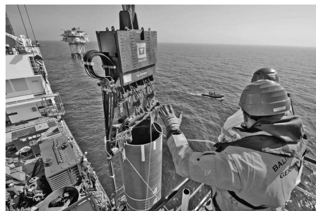
写真—4 MS-200 HHF による鋼製トライポッド打設状況
