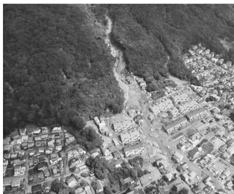
写真1-2 広島県広島市安佐南区八木地区で発生した土石流災害
