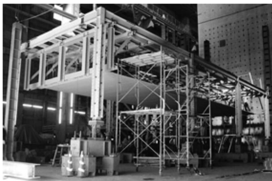
写真—2 大規模天井の加振実験
