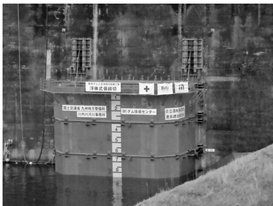
写真一七 設置完了
