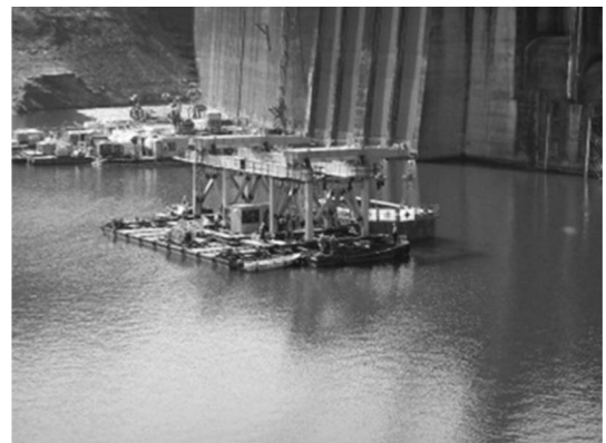
写真一 4 組立後曳航
