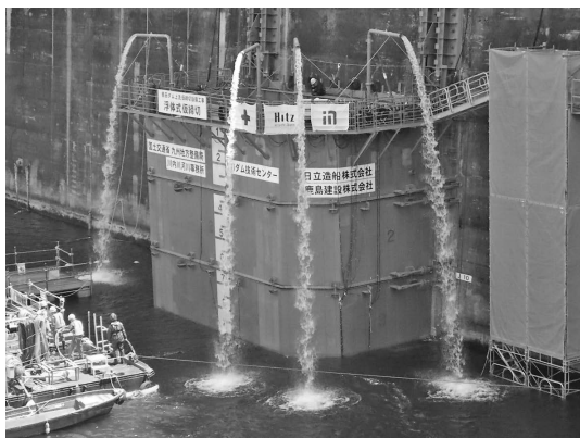
写真一六 締切内排水
