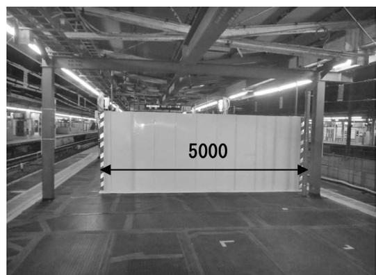
写真-2 仮囲い設置状況 (5m × 8m)
