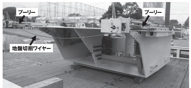
写真一 7 地盤切削 JES 工法の刃口
