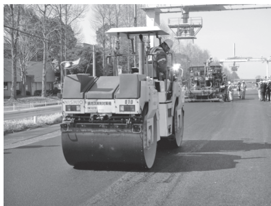
写真一 2 低燃費舗装の試験施工状況
