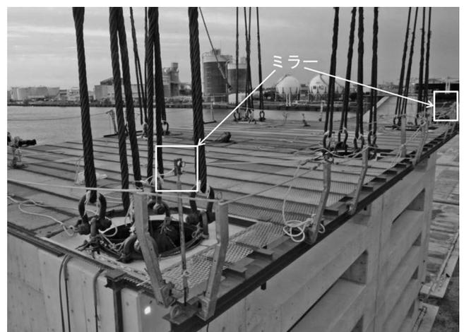
写真一九 函体陸側両端2箇所に設置されたミラー
