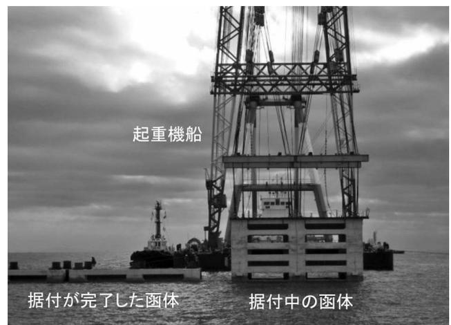
写真-6 起重機船による函体据付
