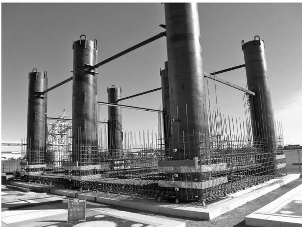
写真-3 ガイド管および鉄筋組立て
