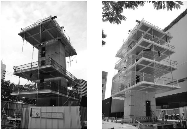
写真-4 リフトアップ工法による2階～4階床スラブの施工
