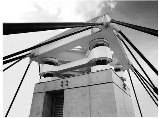
写真-2 コアシャフト頂部の免震装置（積層ゴム4台×2段）
